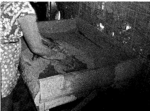
写真35 台上で粉末粘土に砂を混ぜて手練り
