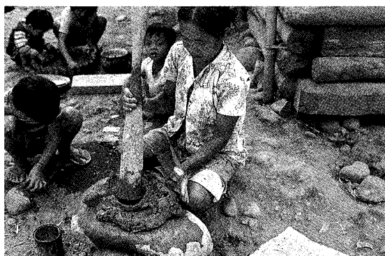
写真65 台石上で杵で短時間土練り
