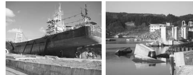
内陸深く乗り上げられた大船と破壊された堤防
