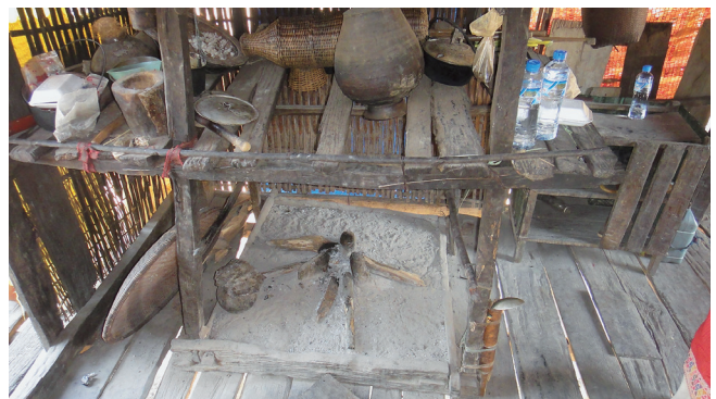
図 3h 箱イロリの四隅に立てた柱で支える火棚。 低い位置に簡易火棚もあるH211
